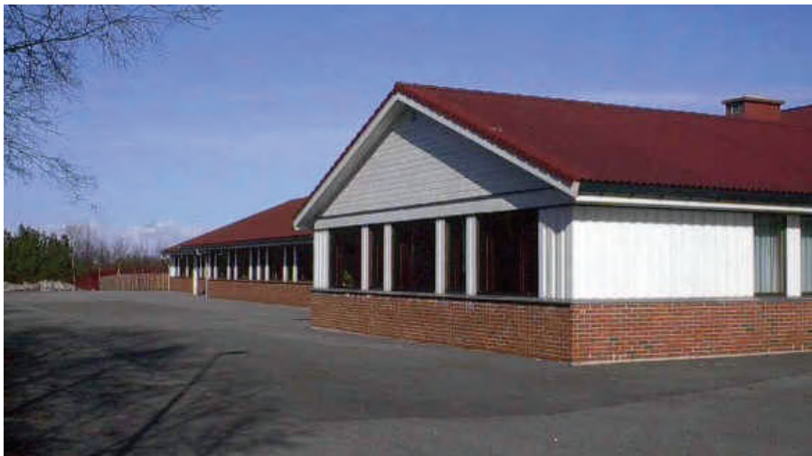
Varhaug ungdomsskule (foto: Hå kommune)
